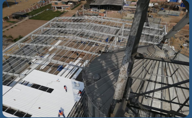
ESTRUCTURAS CON VIGA H - LURÍN
