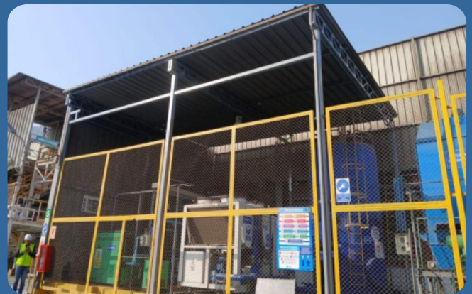
SERVICIO DE LIMPIEZA Y PINTADO DE ESTRUCTURAS - TECHOS ENERGÉTICOS QROMA PLANTA ÑAÑA
