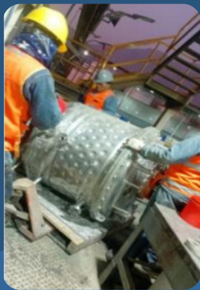
SERVICIO DE FABRICACION DE OVERHAUL PLANTA PILOTO - QROMA PLANTA ÑAÑA
