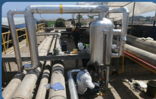
SERVICIO DE INSTALACIÓN DE DESHIDRATADOR DE AMONIACO PLANTA SAN FERNANDO CHINCHA
