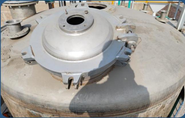
FABRICACIÓN E INSTALACIÓN DE REACTOR QUÍMICO DE 15 TN
