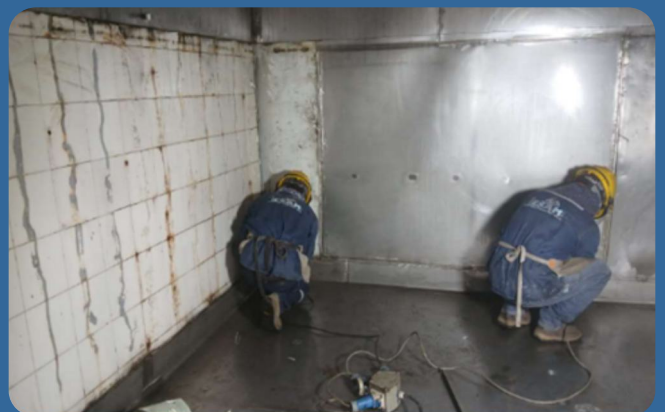
SERVICIO DE ENCHAPADO EN CÁMARA PRODUCTORA DE HIELO SAN FERNANDO PLANTA CHORRILLOS
