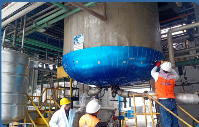
SERVICIO DE IMPLEMENTACIÓN DE CHAQUETA EN TAPA INFERIOR DEL TANQUE R29 QROMA ÑAÑA
