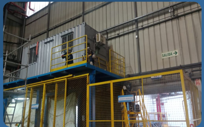
SERVICIO DE FABRICACIÓN E INSTALACIÓN DE ESTRUCTURA METÁLICA MEZANINE MONTAJE DE MODULO CONTEINER PARA EL PROYECTO IRIS QROMA PLANTA EL AGUSTINO
