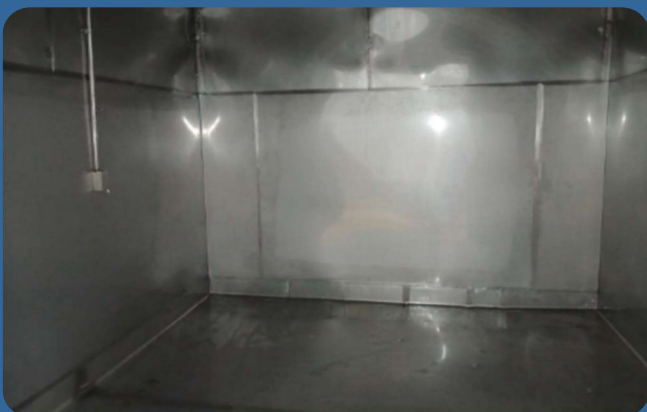
SERVICIO DE ENCHAPADO EN CÁMARA PRODUCTORA DE HIELO SAN FERNANDO PLANTA CHORRILLOS
